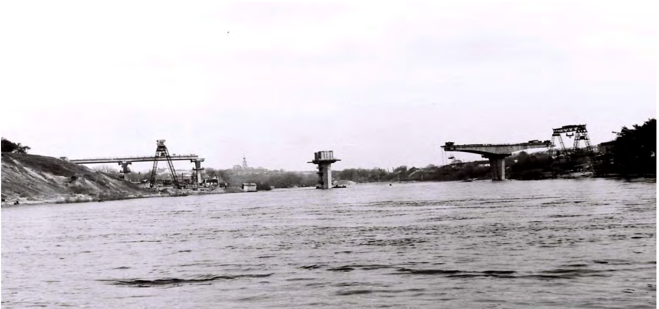
Рисунок 2 – Строительство моста (Вид с русла)
