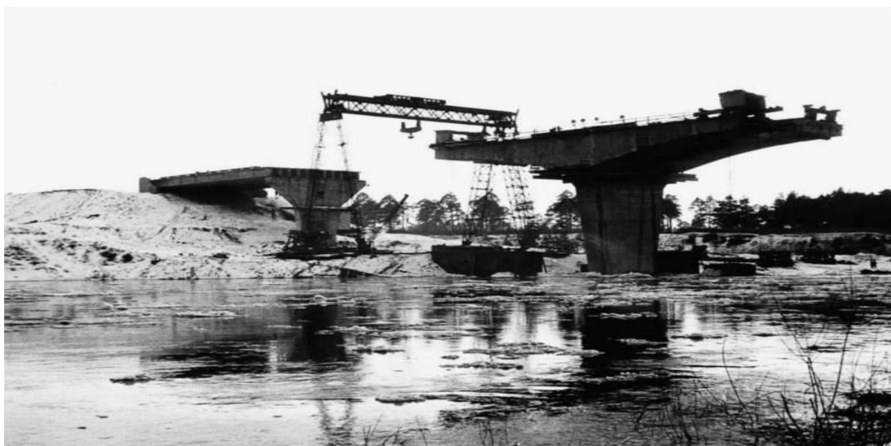
Рисунок 1 – Строительство моста (Вид с берега)
