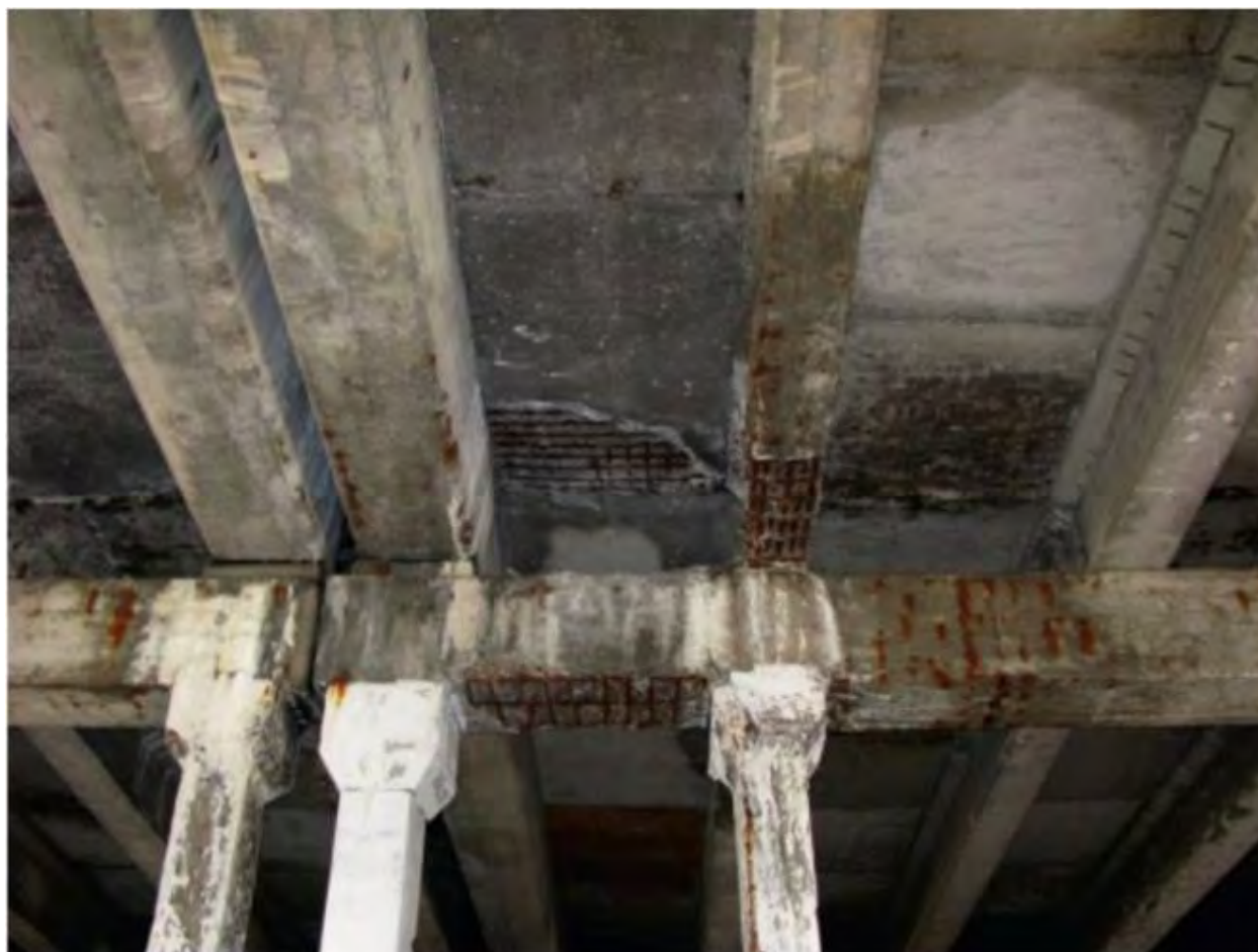
Рисунок 2 – Коррозия арматуры
