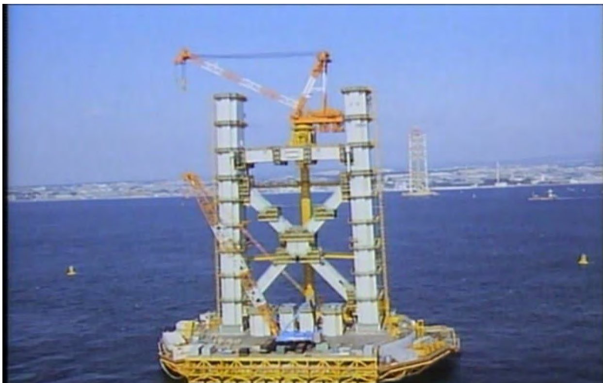
Рисунок 3 – Плавающие платформы, используемые для строительства моста Акаши-Кайкё
