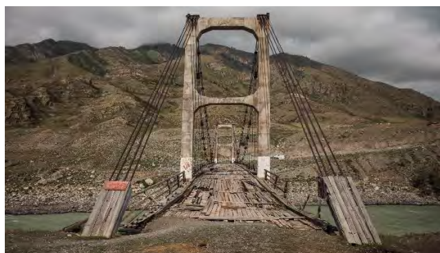
Рисунок 3 – железобетонные пилоны-рамы
