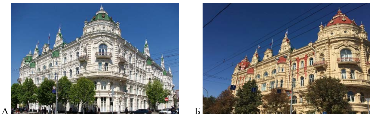
Рис. 3. Здание Администрации города Ростова-на-Дону, ул. Большая Садовая, 47 А – отделка фасада здания с 1995 г. по 2015 г. [2]; Б – отделка фасада здания с 2016 г. по настоящее время [3]
