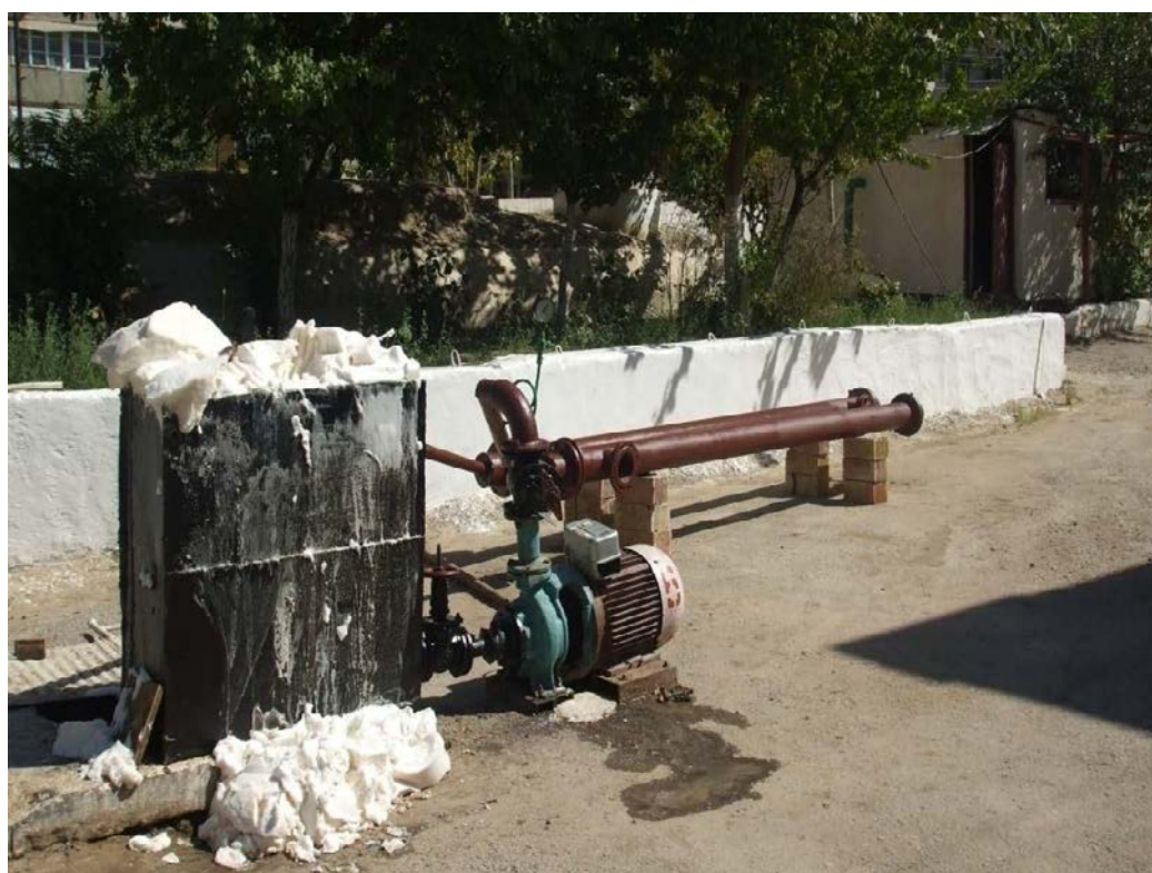
Рис. 2. Состояние экспериментально-испытательной установки и образование пены во время очистки
