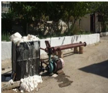
Рис. 2. Состояние экспериментально-испытательной установки и образование пены во время очистки
