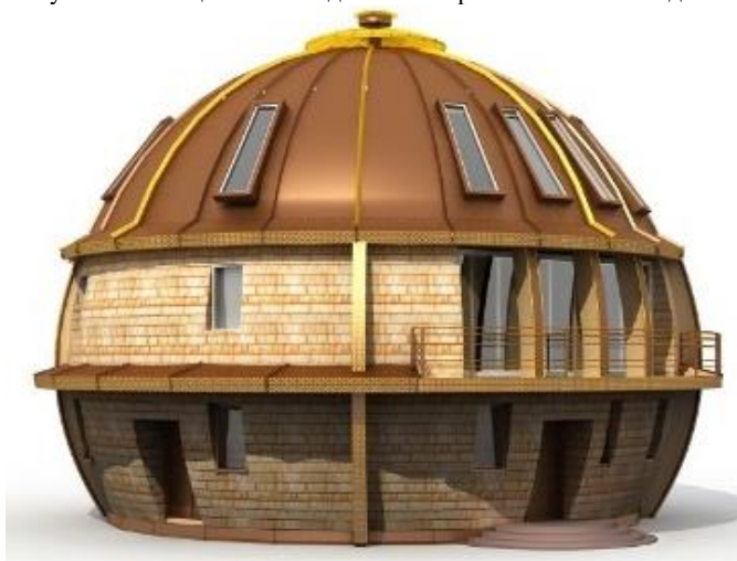
Рисунок 2 – Общий жилого дома со стороны технического входа.
