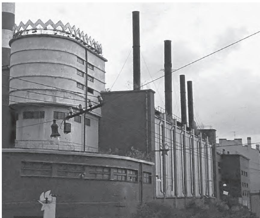
Рис. 1.1.7. Силовая подстанция в Ленинграде, СССР
