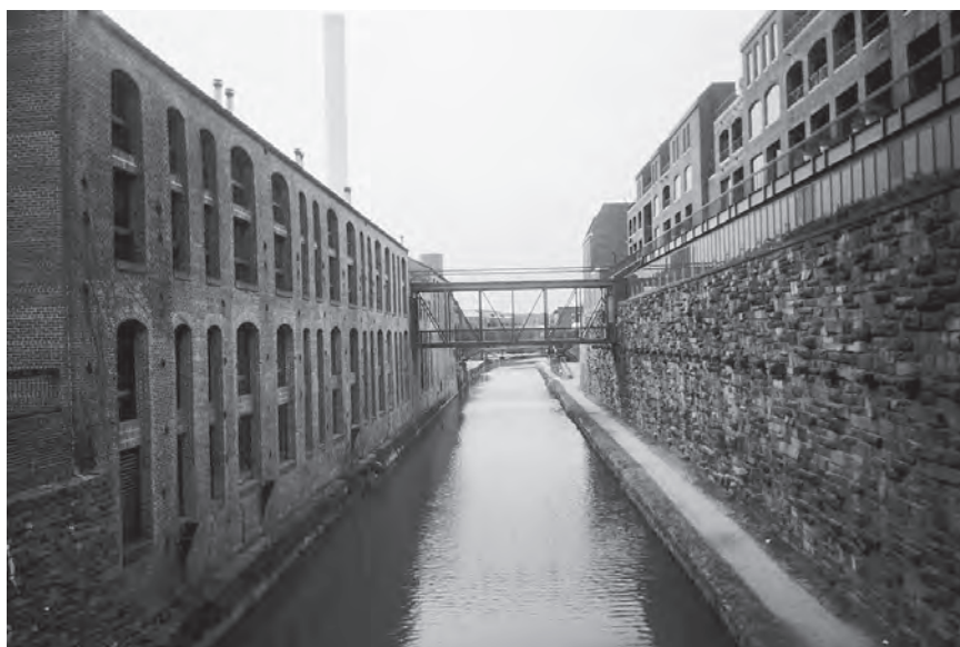
Рис. 2.1.2. Размещение производственных корпусов вдоль канала
