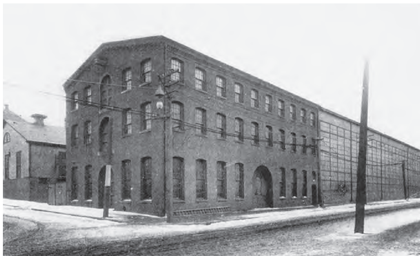
Рис. 1.3.2. Расширение производственного корпуса, США
