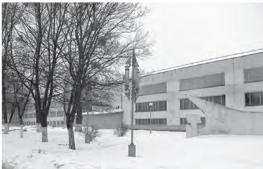
Рис. 4.2.6. Застройка основных магистралей промышленного узла в Бресте — ковровый комбинат, современное состояние
