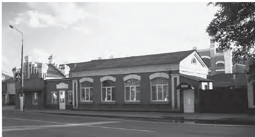
Рис. 2.3.16. Общественная постройка Добрушской бумажной мануфактуры, Беларусь (современное состояние)
