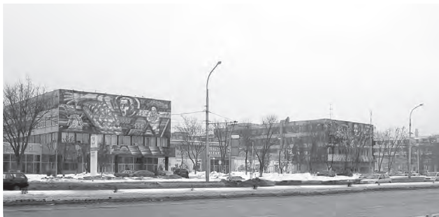
Рис. 4.2.8. Застройка основных магистралей промышленного узла в Бресте — ковровый комбинат, современное состояние
