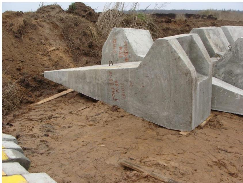
*Рис.4.12 – Пирамидальная свая с нишей для опоры вышележащих конструкции*
