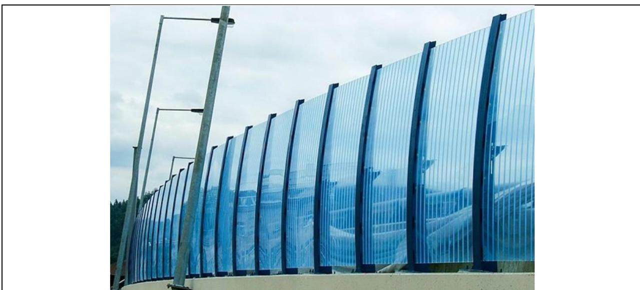
Рисунок 7. Шумозащитный экран
