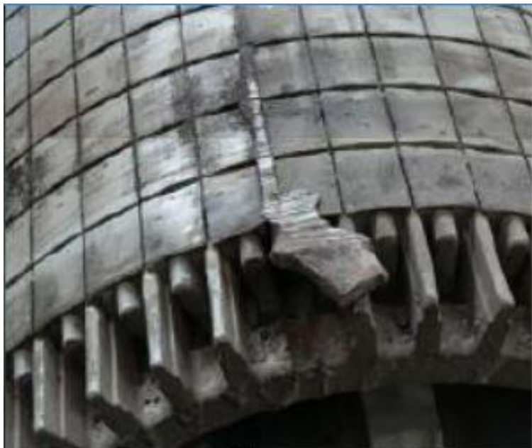
Рисунок 2 Последствия обрыва стержня ротора
