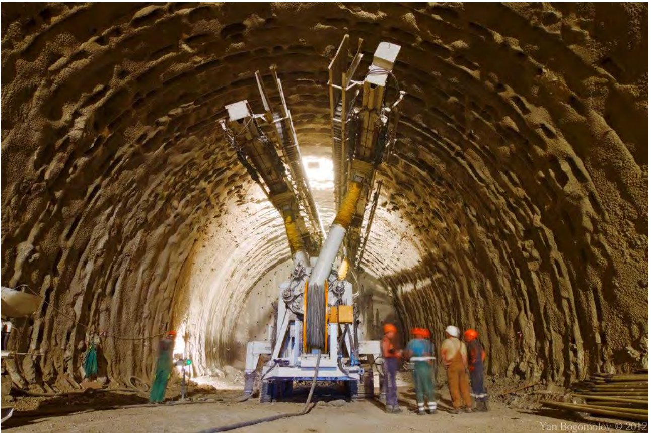
Рисунок 2 – Возведение тоннеля
