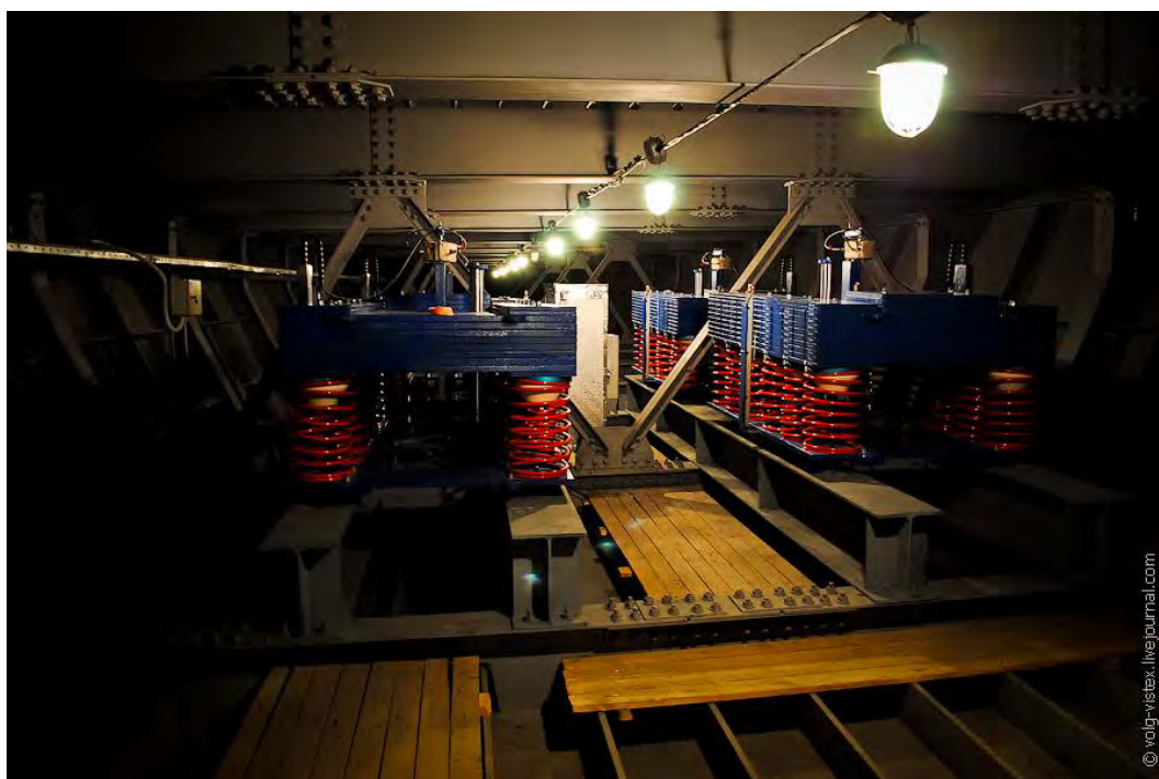
Рисунок 2 – Полуактивные демпферы массы ATMD-V-5200
