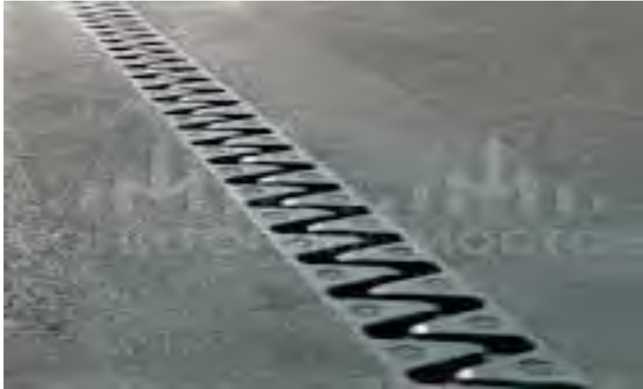
Рисунок 1 – Пример деформационного шва
