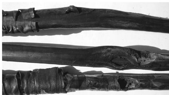
Рис. 2. Повреждения изоляции кабеля: а – силового; б – одной жилы; в – в разобранной муфте
