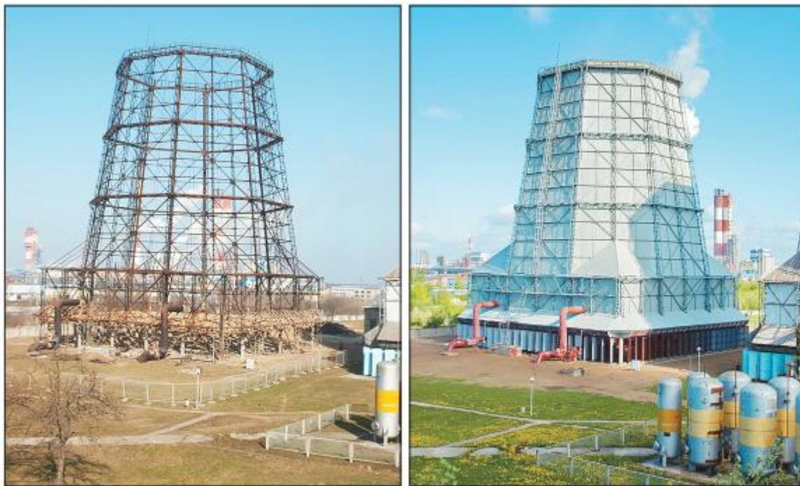
Рисунок 1 – Градирня № 2 Гродненской ТЭЦ-2: после демонтажа обшивки, март 2014 года (а) и после реконструкции, май 2015 года (б)
