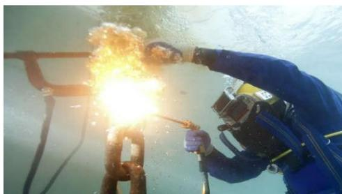
Рисунок 1 - Сварка под водой
