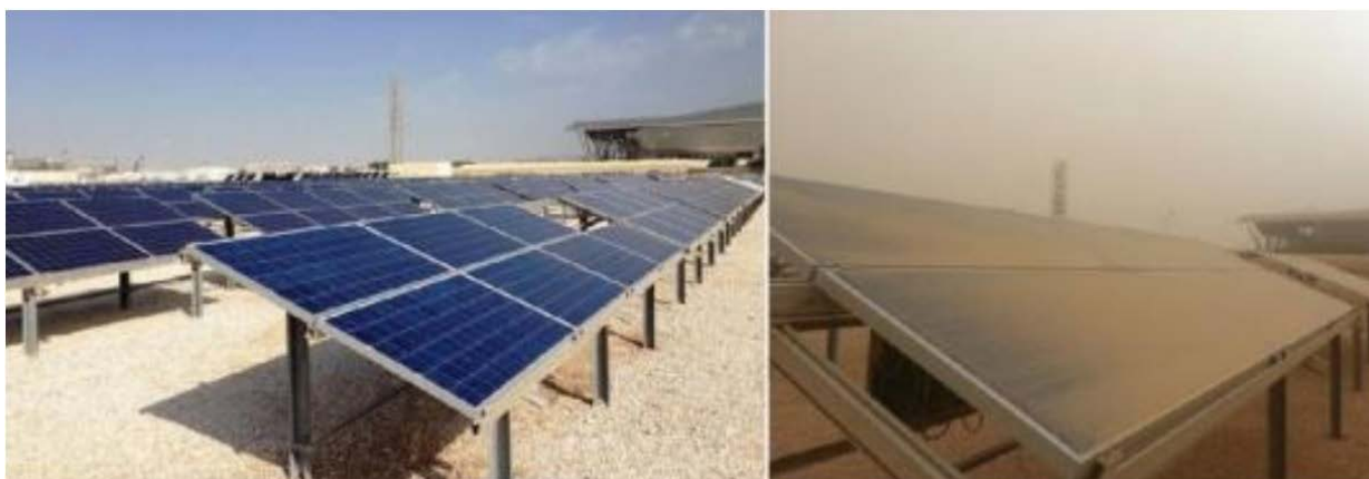
Рисунок 1. Вид солнечных панелей до и после песчаной бури.
