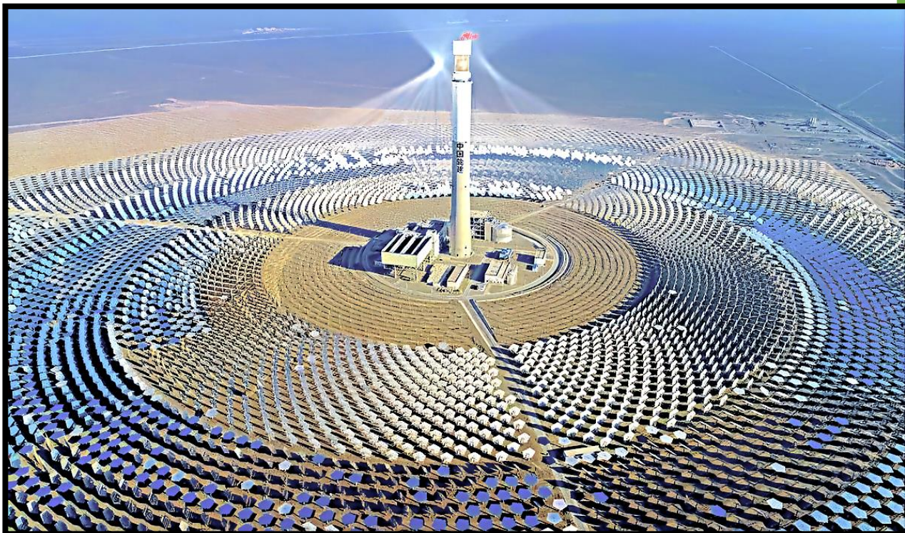
Рисунок 1 – тепловая солнечная электростанция
