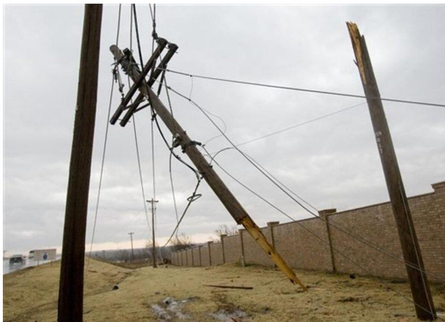
Рисунок 1 – Пример аварии, вызванной сильным ветром
