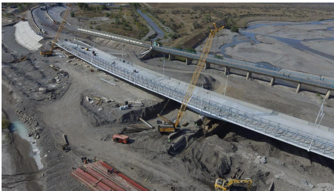
Рисунок 2 – Стройка нового моста над рекой Самур
