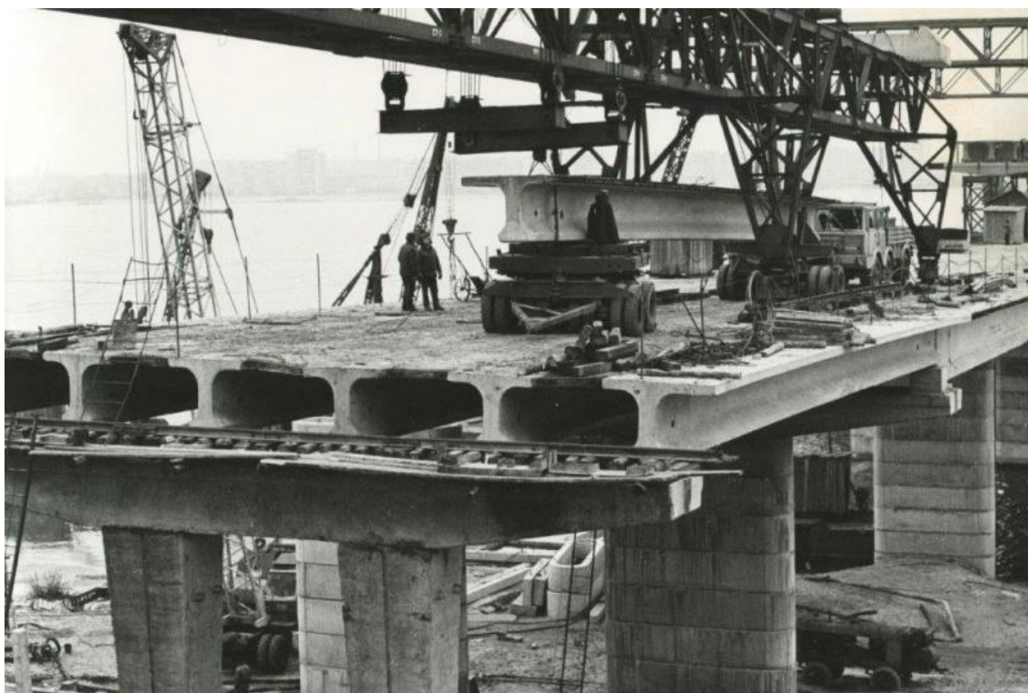
Рисунок 1 – Строительство Северного моста
