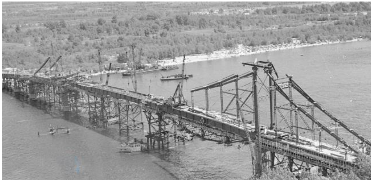
Рисунок 2 – Возведение Паркового моста
