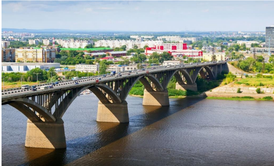
Рисунок 2 – Молитовский мост после реконструкции
