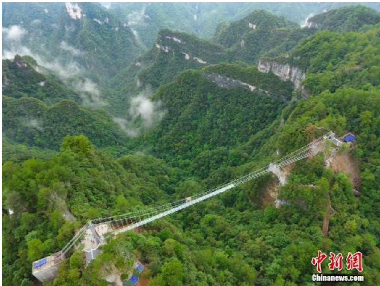
Рисунок 2 – Стеклоанный мост Юньтайшань
