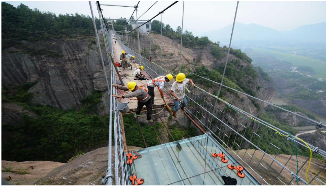
Рисунок 3 – Строительные работы на мосту Юньтайшань
