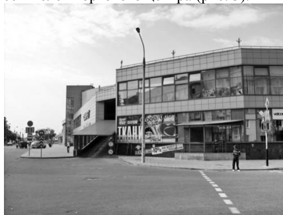
Рис. 3 Торговый центр «Секрет» (вид со стороны въезда в паркинг)
