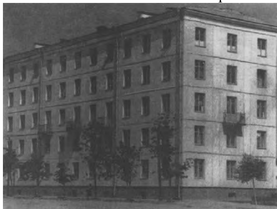
Рис. 2. Первый в республике крупнопанельный жилой дом на 30 квартир на ул. Калинина. 1956г.
