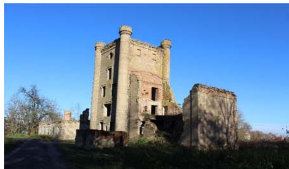
Рис. 12. Здание водонапорной башни в д. Борисовщина, Хойницкий район, Гомельская область
