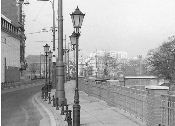
Il. 2. Widok na ul. Grodzką po przebudowie Źródło: Praca zbiorowa: "Rewitalizacja obiektów inżynierskich umiejscowionych w historycznym środowisku", VI Krajowa Konferencja Estetyka Mostów, Warszawa – Jachranka, 16-18 kwietnia 2008r.
