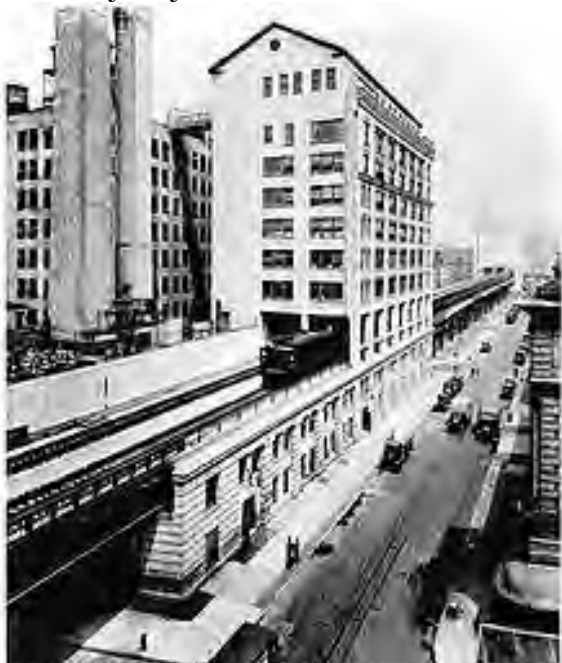
Il. 4. Pociąg linii High Line przejeżdżający przez budynek Bell Laboratories Building (rok 1936). źródło: en.wikipedia.org/Wiki/High_Line (New York City)
