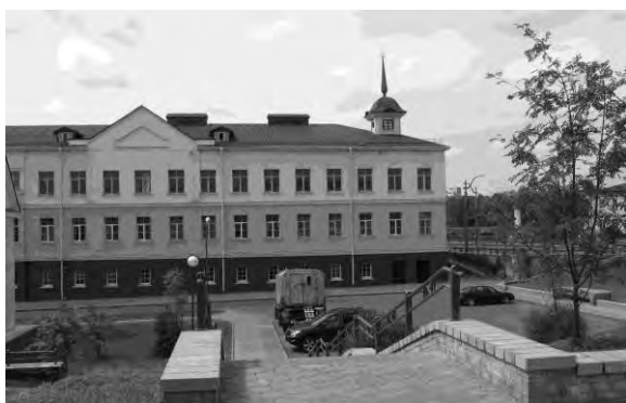
Рис. 4. Реконструкция фасада производственного корпуса
