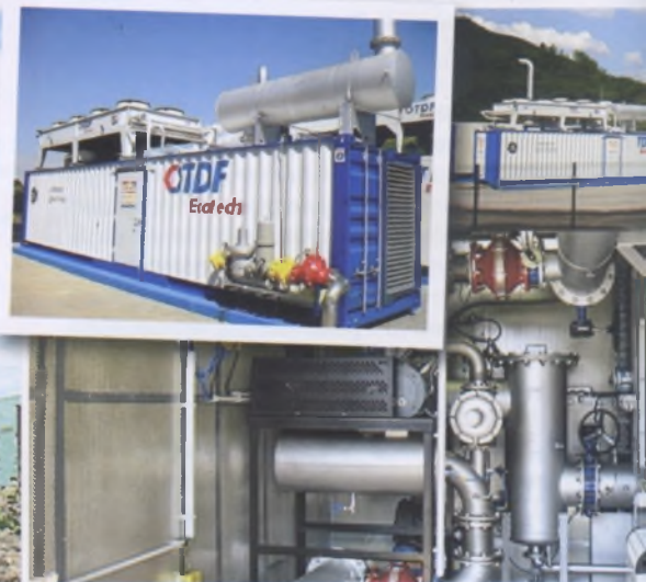
Две газопоршневые установки мощностью по 1 МВт, работающие на свалочном газе, введены в действие на полигоне ТКО «Тростенец». Их годовой экономический эффект – 2,24 тыс. т у.т., или 470,4 тыс. $; срок окупаемости проекта 4,8 года
