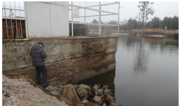
Рисунок 6 – Низовая стенка правобережного устоя
