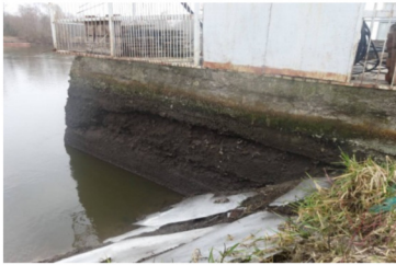
Рисунок 2 – Верховой открылок правобережного устоя
