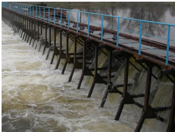
Рисунок 1 – Затвор с поворотными фермами «Поаре»
