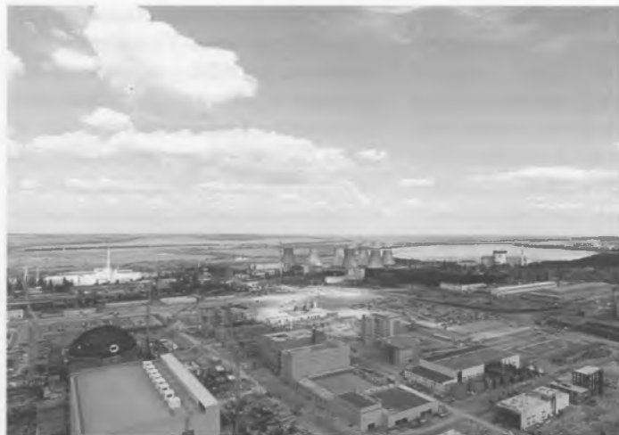
Рис. 1. Вид на стройплощадку Новovoroneжской АЭС-2 (на фоне работающего блока № 5)
