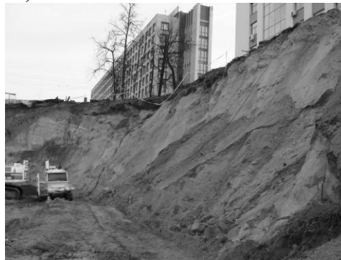
Рис.10.1. Оползневый участок Гапеева ручья в г.Витебске -а); откос котлована строящегося торгового центра «Марко-Сити» в г.Витебске–б);
