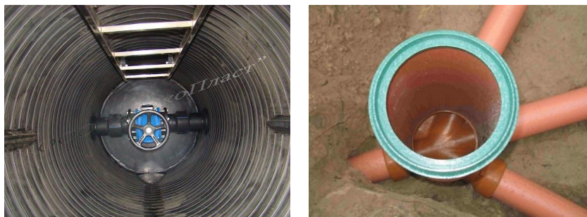
а б Рис. 2. Колодец из полимерных материалов: а – водопроводный; б - канализационный
