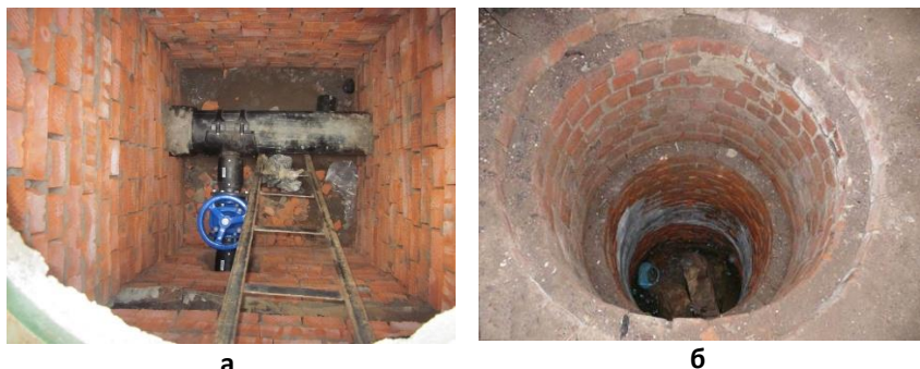
Рис. 1. Кирпичный колодец: а – водопроводный; б - канализационный
