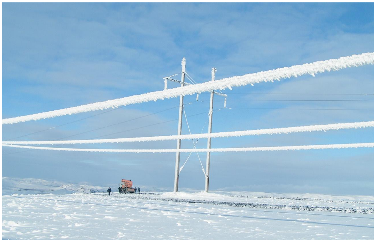
Рис. 6. Обледенение проводов ЛЭП
