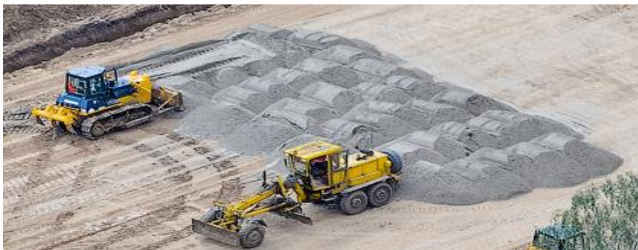
Рис. 1 Схема отсыпки дренажного слоя дорожной одежды
