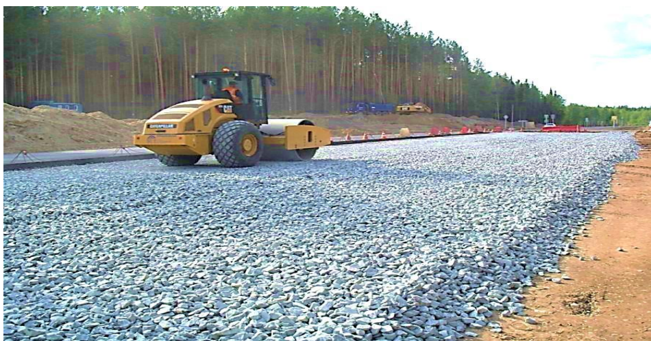
Рис. 2. Схема устройства основания из щебня:
