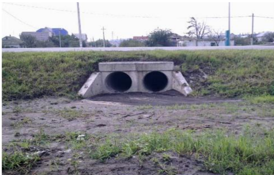
Рисунок 3 – Двухочковая круглая железобетонная труба
