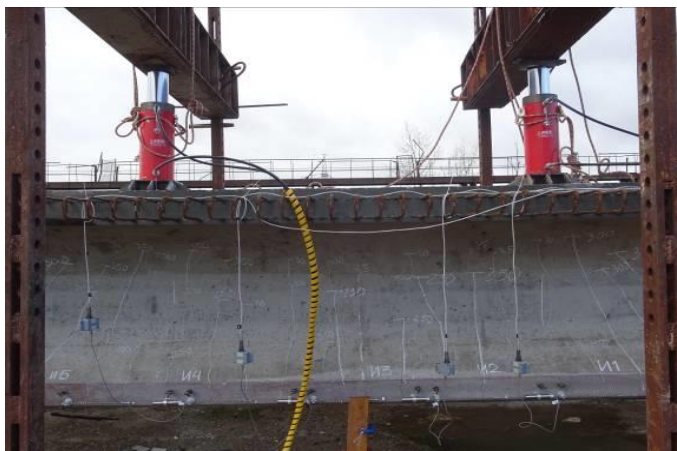
Рис. 1. Вид на установленные на железобетонной балке LVDT-датчики
