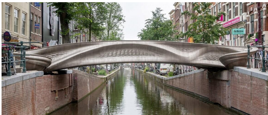
Рис. 2. Мост в Амстердаме (Нидерланды)
