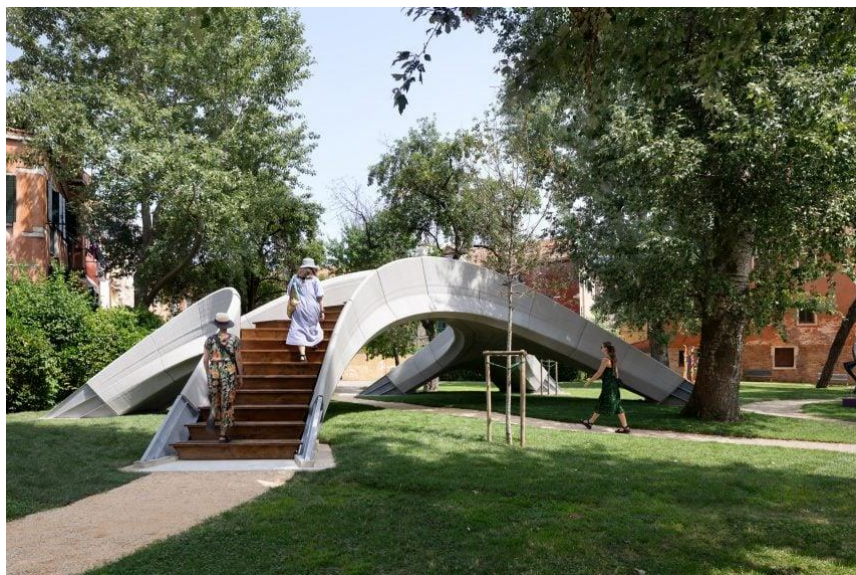
Рис. 4. Арочный мост Стриатус в Венеции (Италия)
