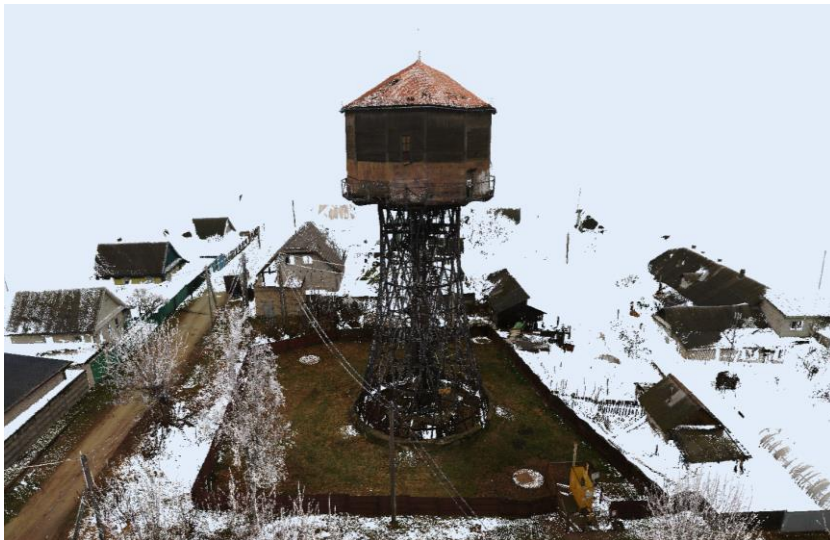
Рис.3. Общее плотное облако точек Шуховской водонапорной башни г. Борисова
