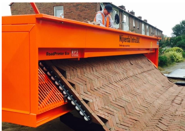
Рис. 1. Укладка тротуарного покрытия с помощью RoadPrinter ECO
