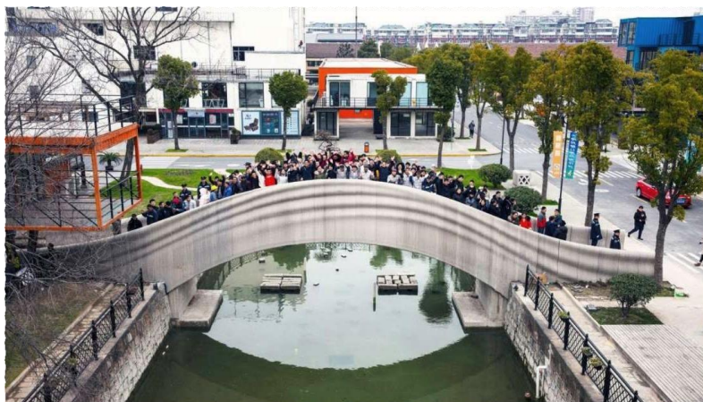
Рис. 1. Мост в пригороде Шанхая Баошань (КНР)
