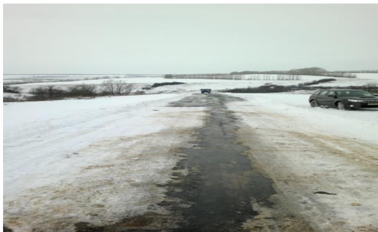
Рис. 2б. Антигололедный асфальтобетон: спустя 3 часа после очистки
