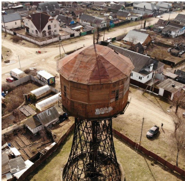
Рис. 1. Общий вид Шуховской башни в г. Борисов, Минская область
