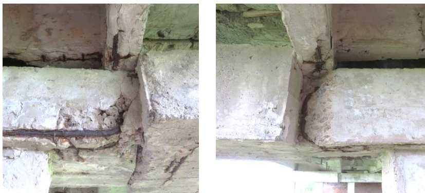
Рис. 7. Мост через р.Солянка на км 304,911 автомобильной дороги Р-43
