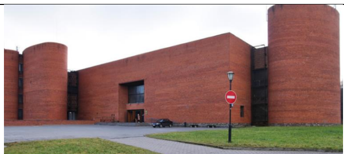
Рисунок 7. Палеонтологический музей имени Ю. А. Орлова в Москве, Россия, архитекторы Ю. Платонов и Л. Яковенко [10]
