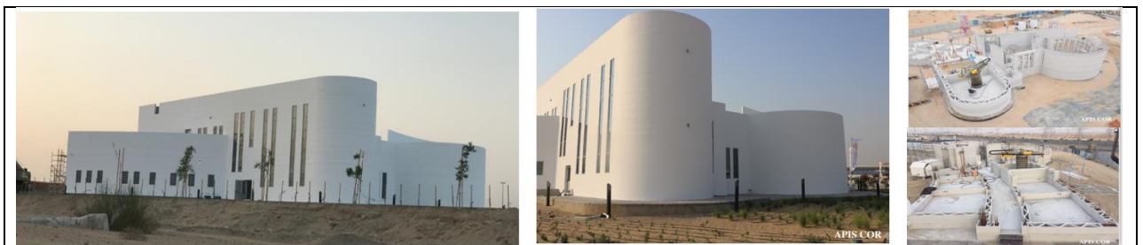
Рисунок 6. Офис муниципалитета, ОАЭ
