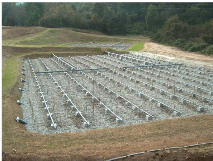
Рис. Вид грунтово-растительной иловой площадки в первый год эксплуатации
