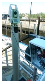
Рис. 1. Тахеометр на пилоне
