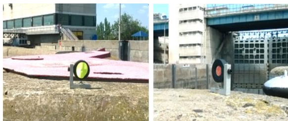
Рис. 2. Отражательные призмы на секциях шлюзов
