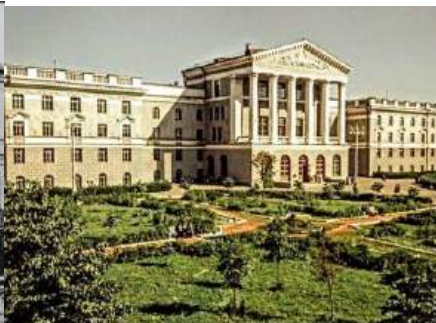
Рисунок 5 – Отстроенный главный корпус БПИ 1960 года
