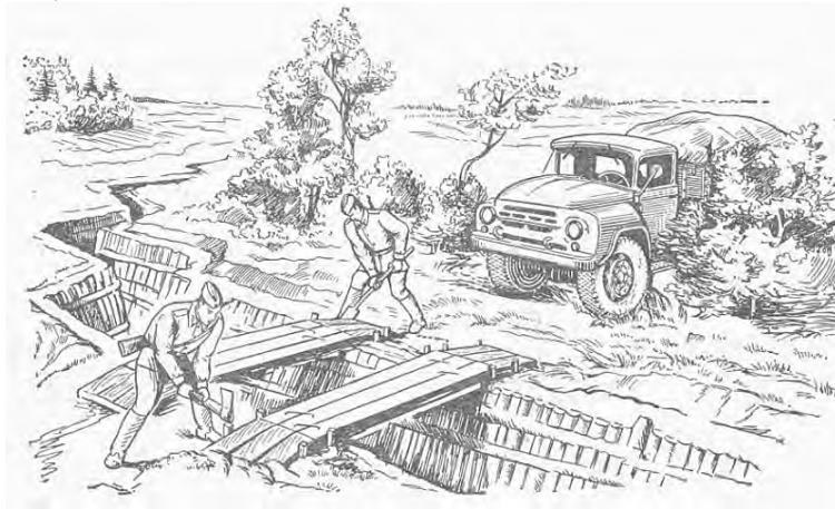
Рис. 3.13. Укладка колейных мостиков через препятствие
