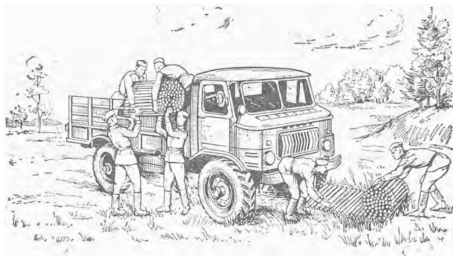
Рис. 3.14. Укладка колейных дорожек из прутьев
