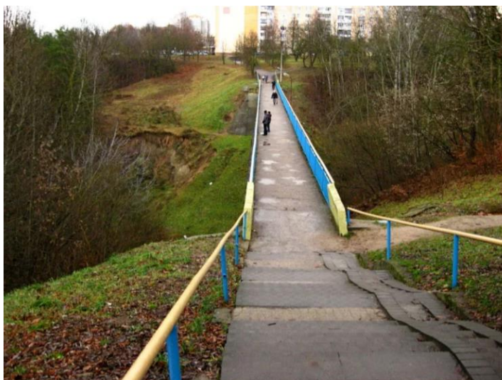
Рисунок 1 – Пешеходный виадук до реконструкции
