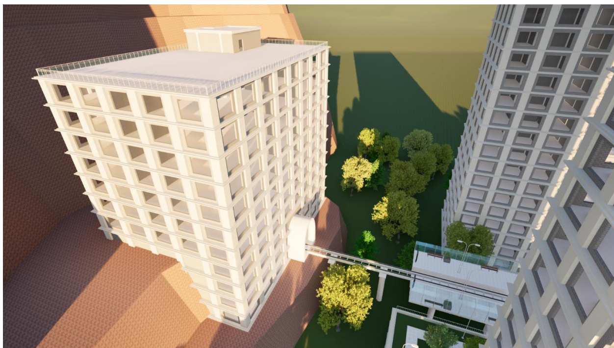
Рисунок 4 – Общий вид здания над порталом
