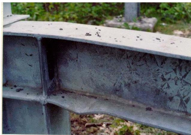
Рис. 1. Вид погиби нижней полки прокатного двутавра
