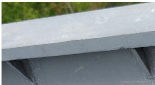
Рис. 2. Вид крепления стенки балки к поясу укороченными ребрами
