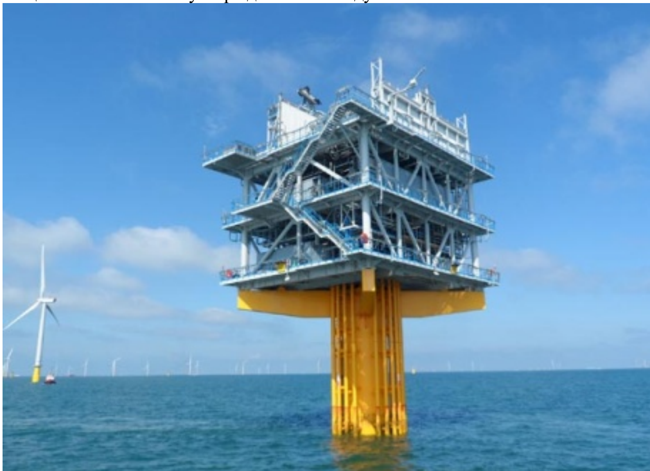
Рисунок 9 – Оффшорная подстанция (фото London Array Ltd.)
