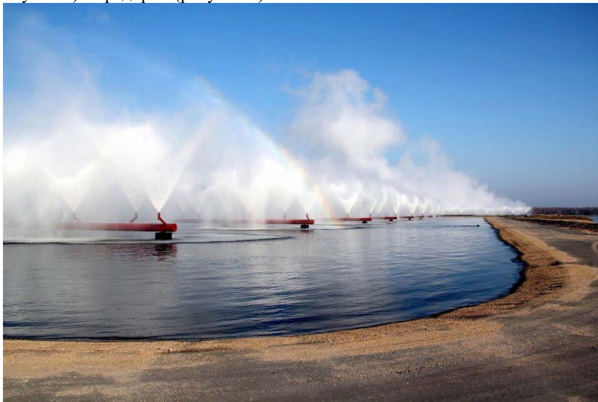
Рисунок 3 – Брызгальные бассейны МТЭЦ-5 [3]
