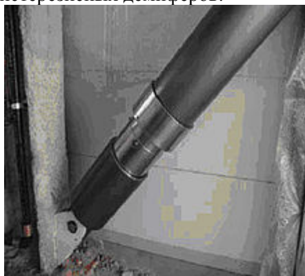
Рис. 4. Жидкостный вязкоупругий демпфер в здании
