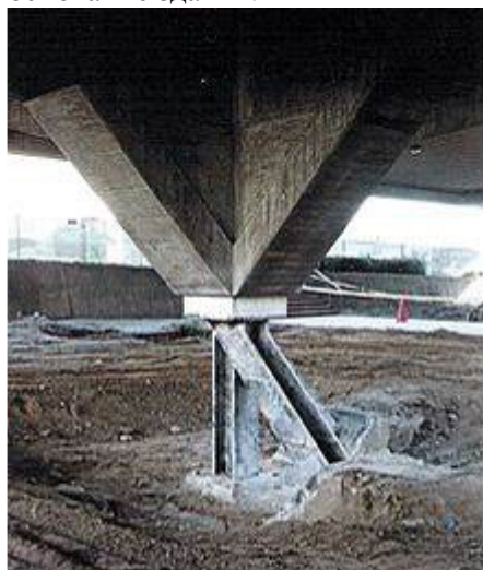
Рис. 5. Реконструкция пяты свода приподнятого основания
