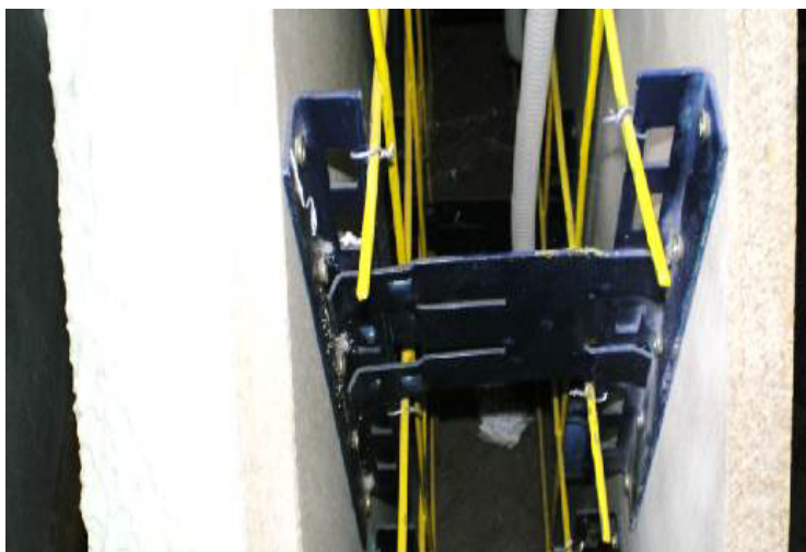
Рис. 1. Фрагмент элемента несъемной опалубки стены из ЦСП
