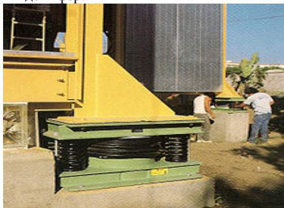
Рис. 6. Пружинный демпфер под трехэтажным домом
